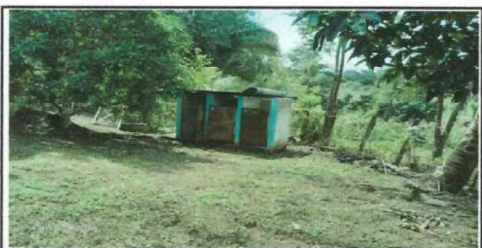
Foto 5: Cambio de techado y pintada del baño.
