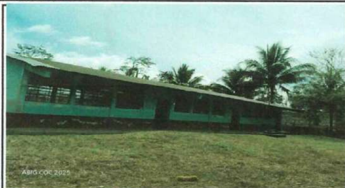
Foto 1: Cambio de Techo de 3 aulas
